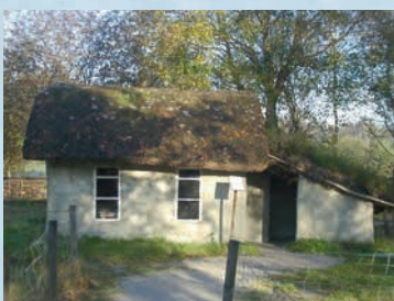
Kolonistenhäuser wurden nicht nur auf Sand gebaut.
